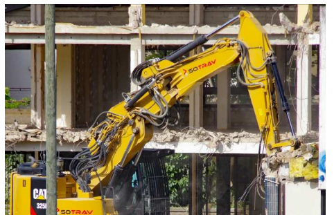
Démolition de l'ancien bâtiment d'Archipel Habitat
