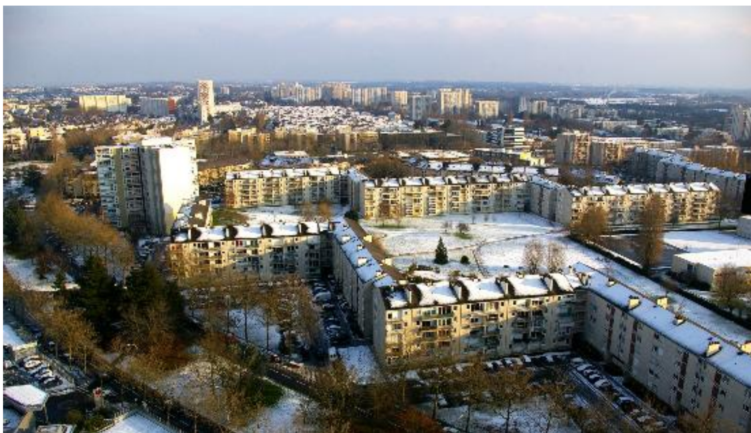
Notre photo: Le square des Hautes Chalais, vu du toit de la Tour Sarah Bernhardt le 18 décembre après la neige
